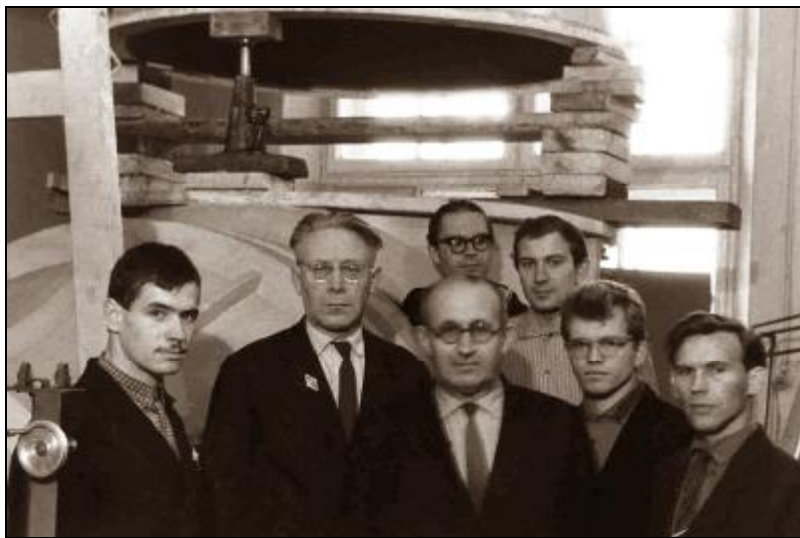
Монтаж аэродинамической трубы, 1964 г. (слева направо 1-й ряд: Н.А. Репях, В.Н. Норин, И.Ф. Верещагин, Ю.А. Урусов, Г.В. Пузанов; 2-й ряд: В. Кетов, неизвестный)
